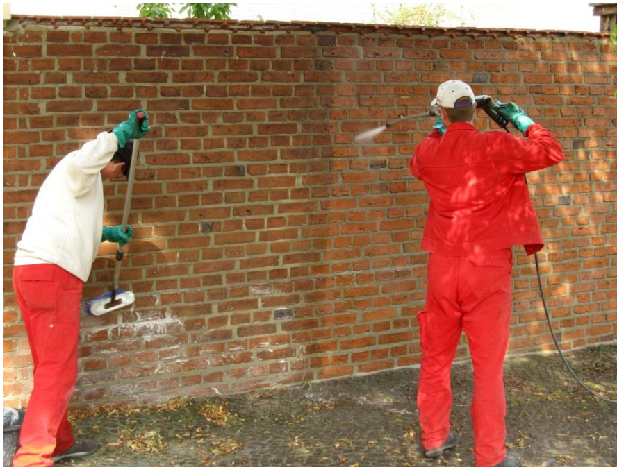
Außenreinigung einer Wand
